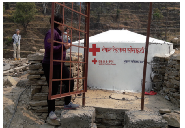
ネパール赤十字社と日赤の支援で新たに設置された貯水槽
